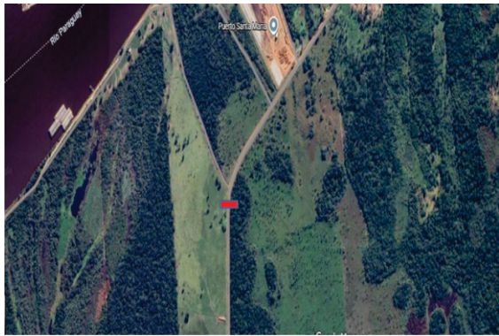
COLOCACION DE TUBO DE 60 CM CAMINO A LA COMPAÑIA POROTO.
