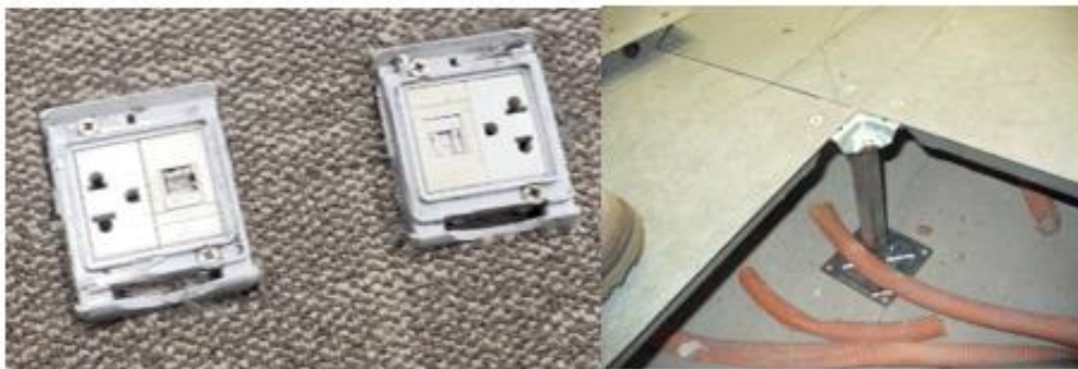
Figura 34 - Toma existente – piso sobreelevado
