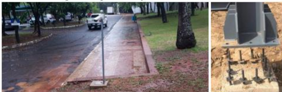
Figura 21 Caminero a ampliar – Ejemplo de base abulonada.
