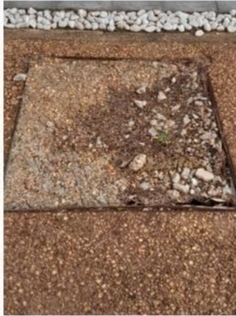
Figura 37 – Estado actual de la tapa
