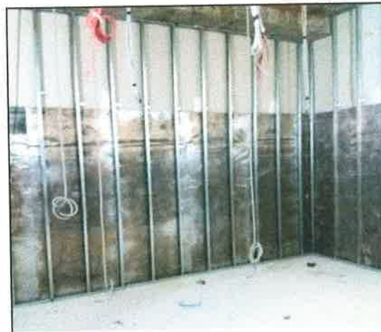
Figura 4 Revestimiento de láminas de plomo en tabiquería de Durlock.
