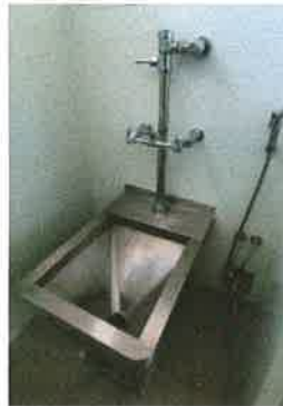
Figura 57 Botadero Clínico De Fluidos Corporales De Acero Inoxidable, Con Todos Sus Accesorios – Imagen de referencia.
