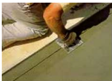
Fig.1. Corte de junta con llana dentada
