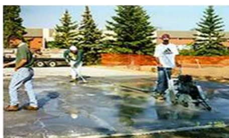
Fig. 2. Corte de junta con aserrado mecánico
