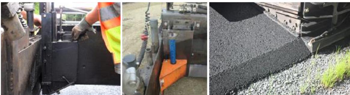
El borde de seguridad se construirá con la misma mezcla de la capa de rodamiento y en forma simultánea con ésta.
