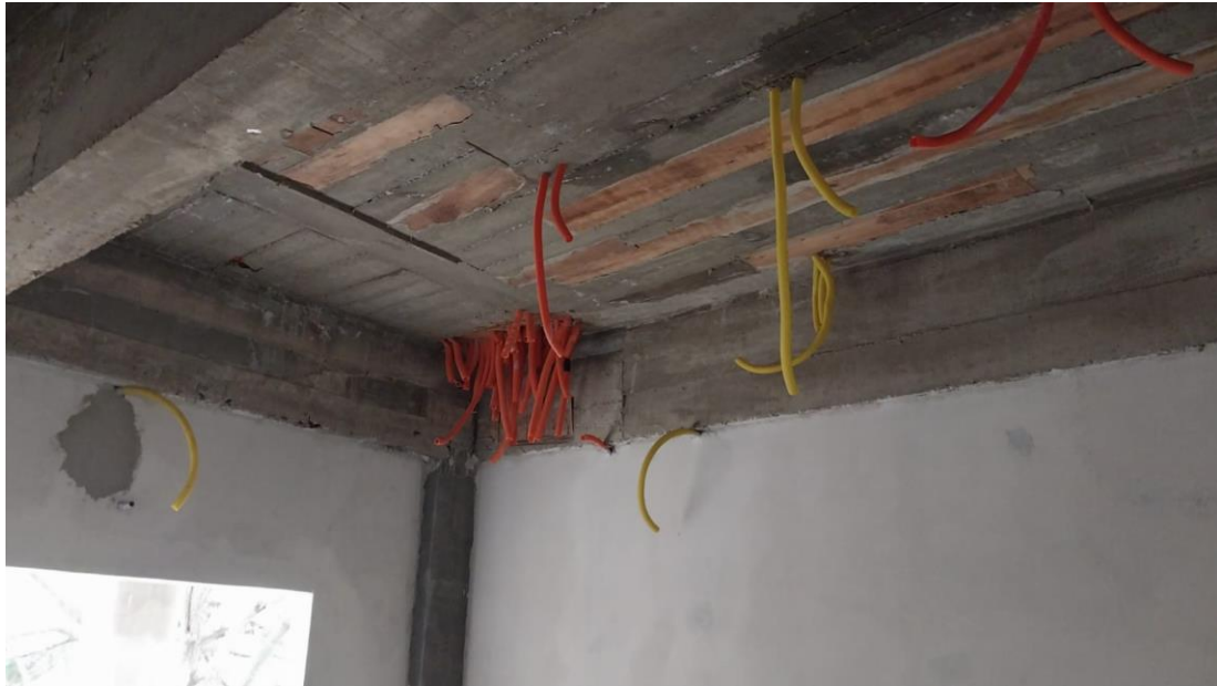
Vista de ductos existentes embutidos en paredes y losas
