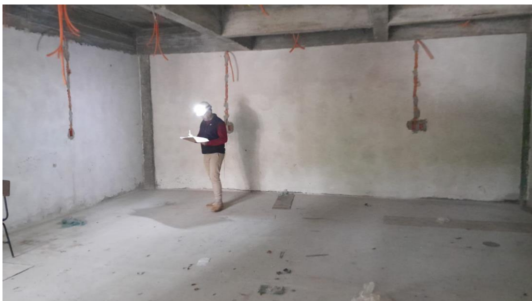
Verificación de ductos y cajas utilizables para sistema de detección.
