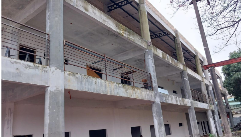
Revocar pilares cilíndricos y de vigas perimetrales de H°A° con mochetas
