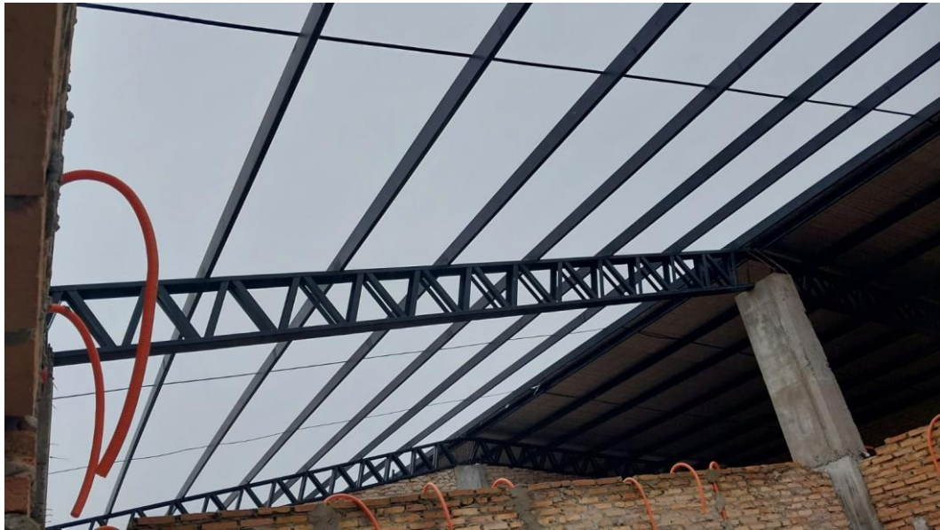
Vista de la otra mitad con las vigas y correas metálicas colocadas
