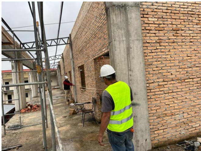
En el segundo piso falta ejecutar revoques en su totalidad
