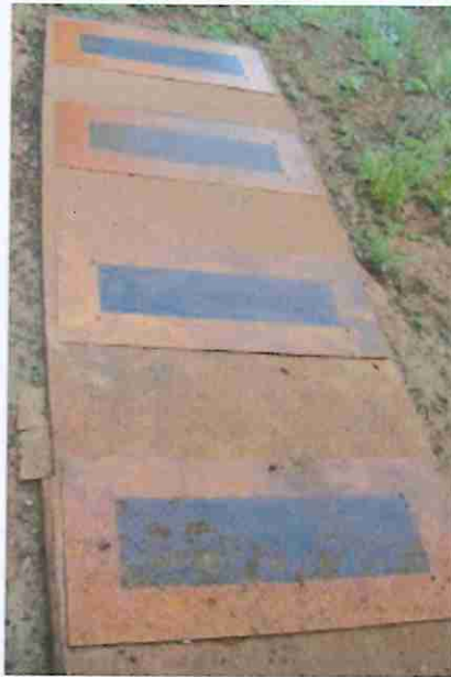
Fotografía 3: Tapas antideslizantes (1 m x 1 m) con 2 manijas embutidas en los extremos
