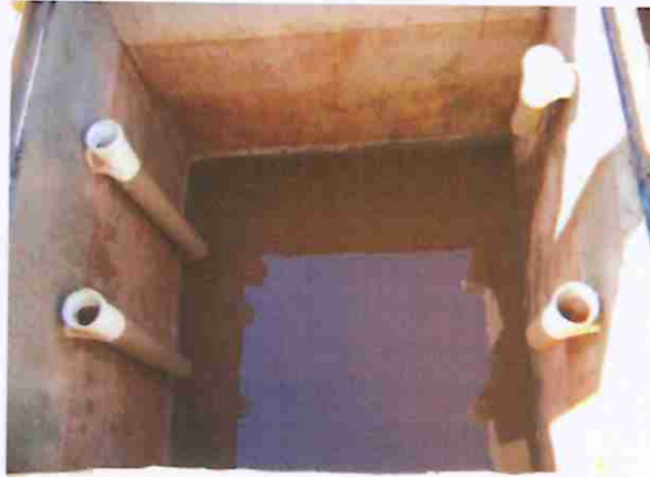
Fotografía 1: Vista de una de las fosas con las cañerías colocadas
