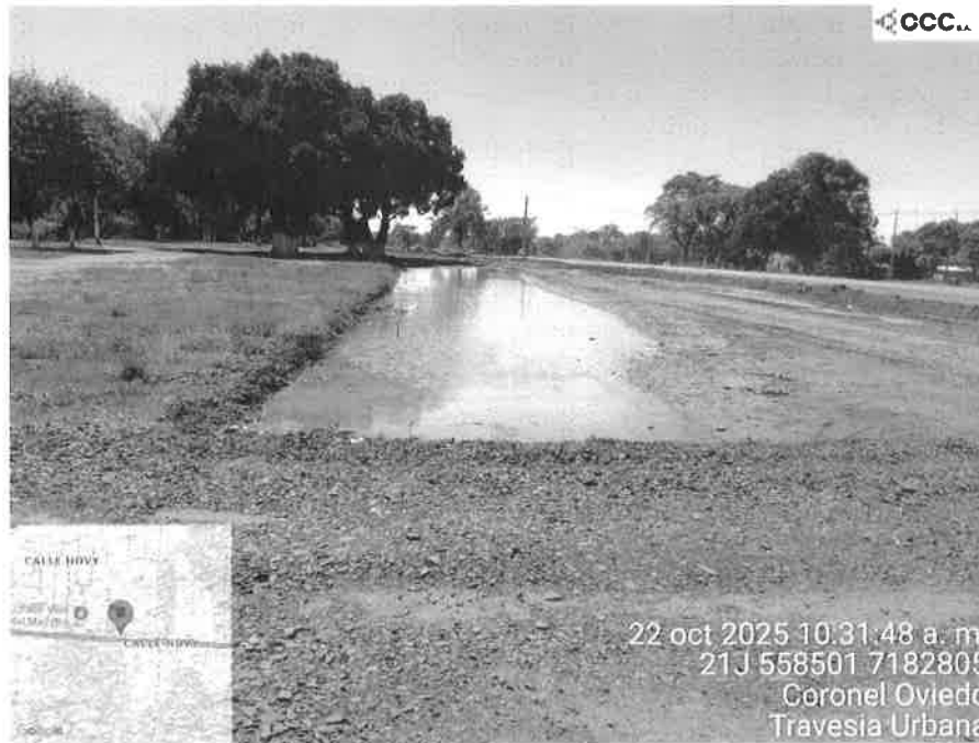
Ilustración 3 Corte para la ejecución de Paquete Estructural. Prog 2+150. Tomadas 4 días después de la precipitación ocurrida en fecha 18-10-2025.
